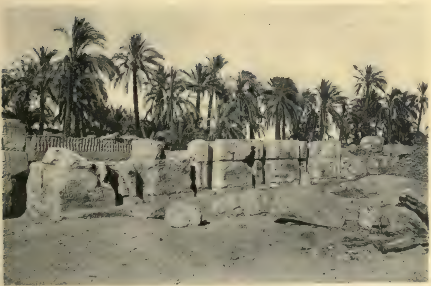
2. Face interne du premier pylône (Aile gauche).
